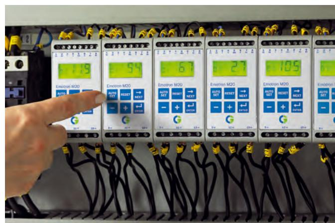
U čerpadel tento monitor nahrazuje drahé a na údržbu náročné součásti systému, jako jsou například snímače průtoku, tlaku a teploty. U drtičů nejsou potřeba žádné bezpečnostní spojky, momentové jističe, koncové spínače ani bezpečnostní kolíky. Nejsou nutné mechanické zásahy do portubí nebo instalace nosných držáků pro umístění snímačů. Tím se výrazně snižuje doba a cena instalace.
